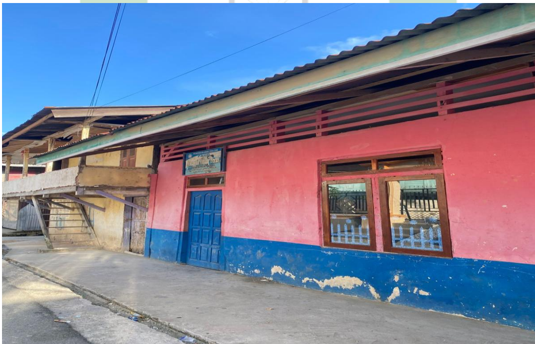
Dokumentasi ruang PAUD Amanah Titian Teras Sungai Deras
