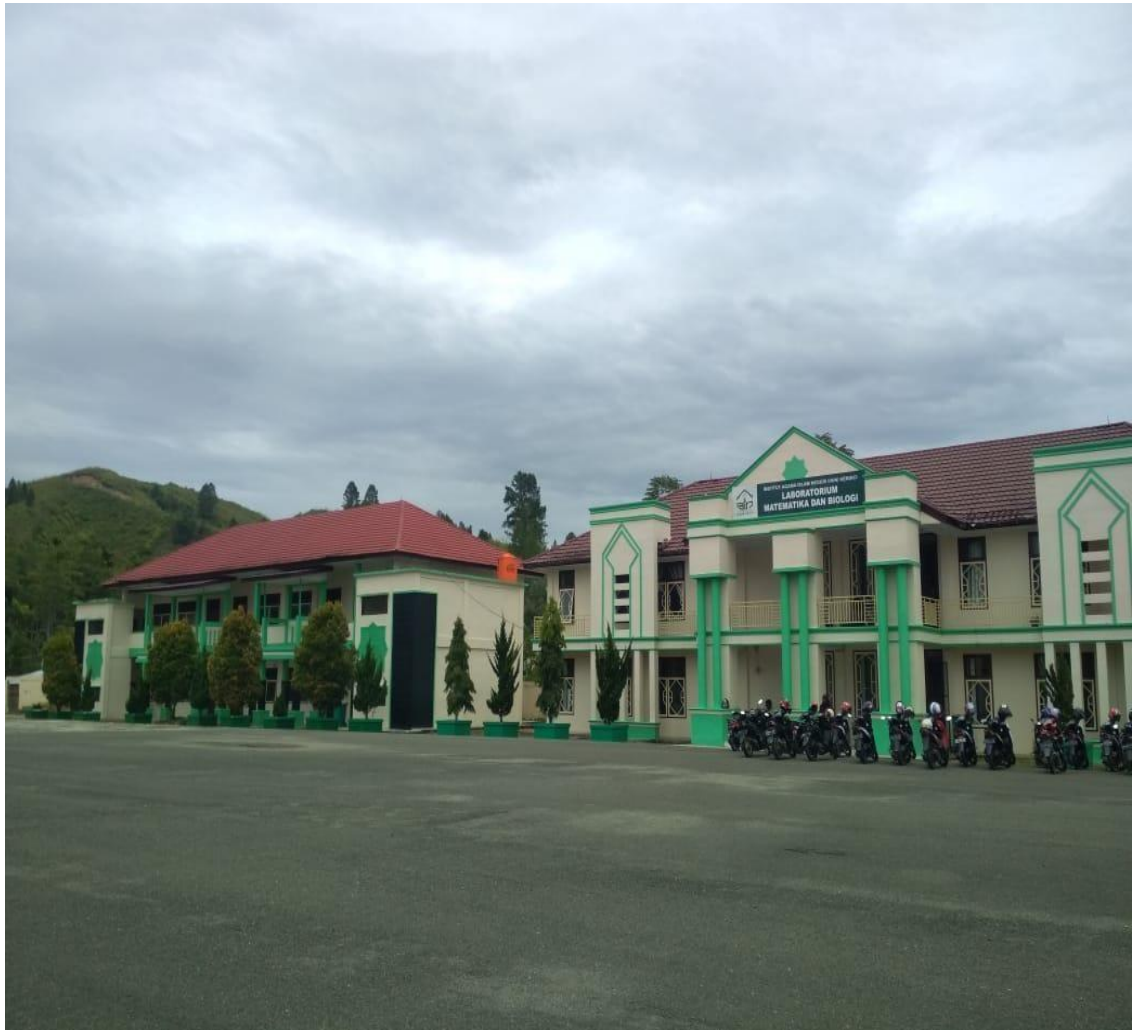
Gedung Biologi dan Laboratorium Matematika dan biologi
