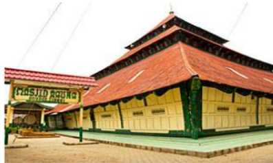
Fig. 1. Masjid Agung Pondok Tinggi
